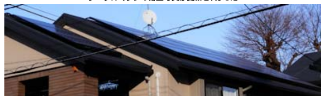
南側屋根ほぼ全面にソーラーパネルを設置
